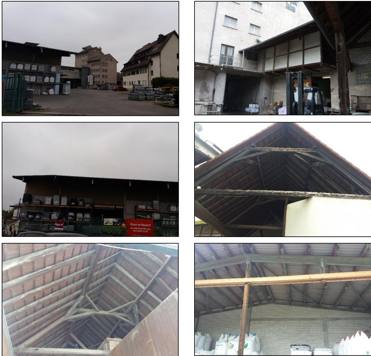
Abb. 2: Ansichten des Planungsgebiets. Oben links: Blick von „Unterer Brühl“ auf das Planungsgebiet, oben rechts: Blick entlang der nordöstlichen Halle, Mitte und unten: Blick auf die verschiedenen Hallen und das Gebälk der offen zugänglichen Hallen.
